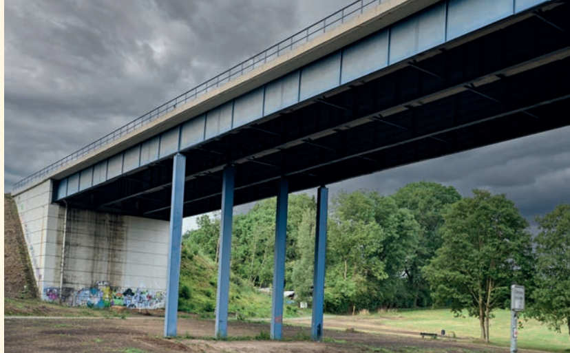
BRÜCKENABRISS AUF DER A 544
