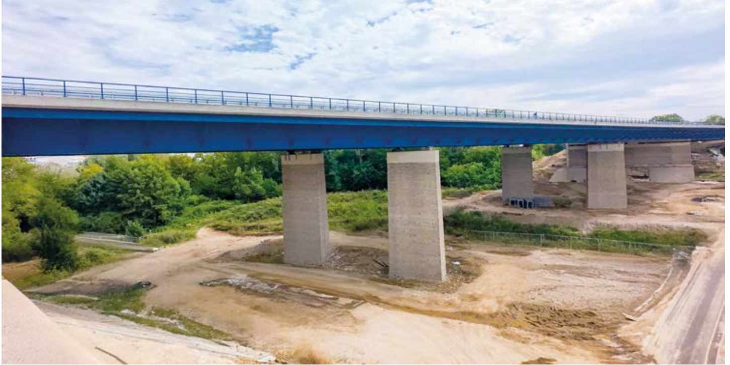
Die neue Haarbachtalbrücke, kurz vor ihrer Eröffnung
